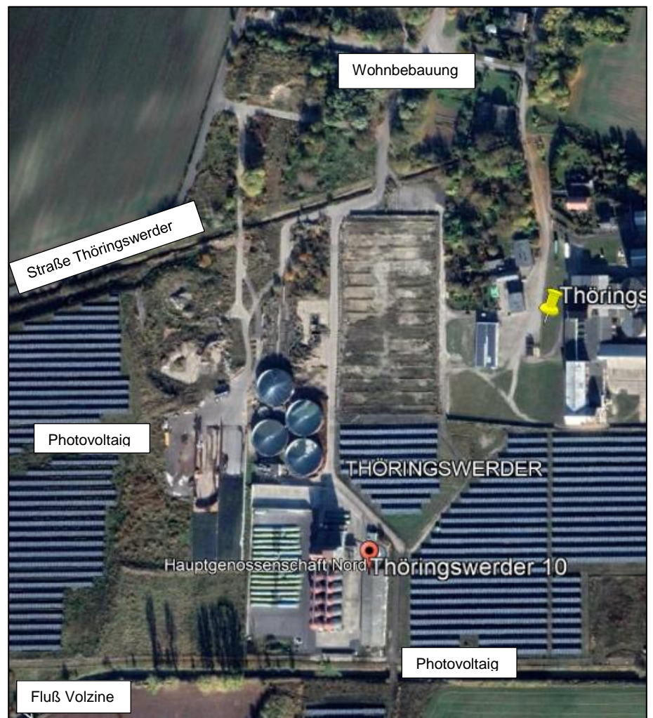
Abbildung 1 Luftbild Biogasanlage /Umgebung 1
